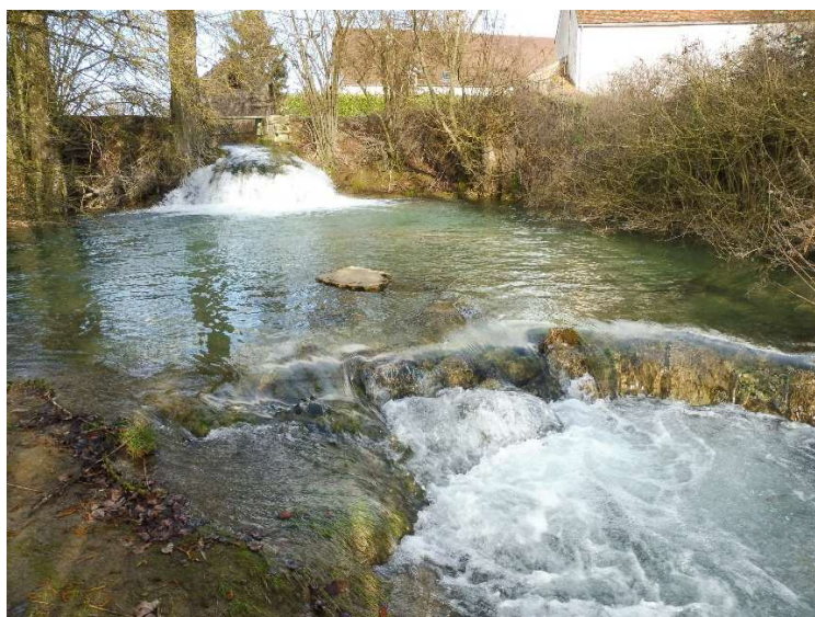
Vue sur les deux chutes au droit du Moulin de la Ferme de la Folie
