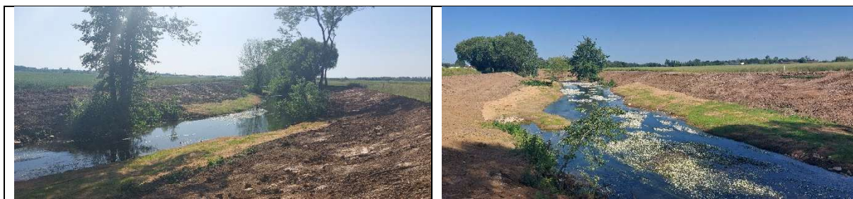
Photographies des Travaux
