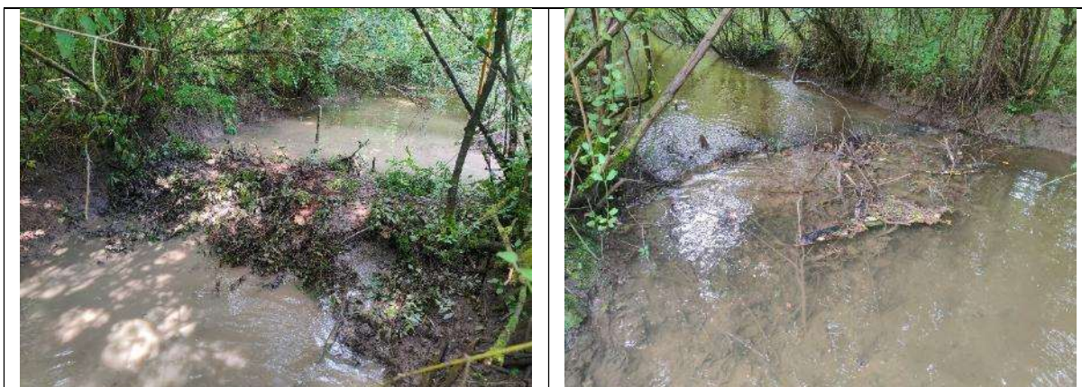
Travaux terminés le 26 juin 2025
