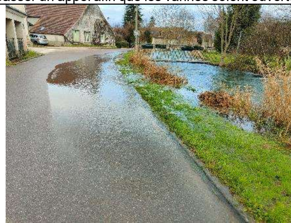
Débordement de la Vouge à la rupture de pente
