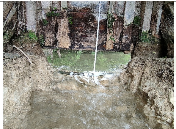
Vannes latérales du moulin (~ 20 cm de baisse)
