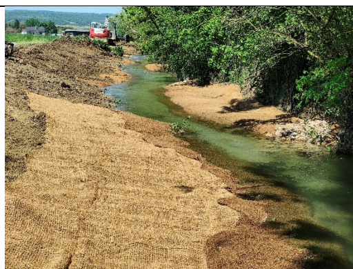
Mises en place de banquettes – avril 2025
