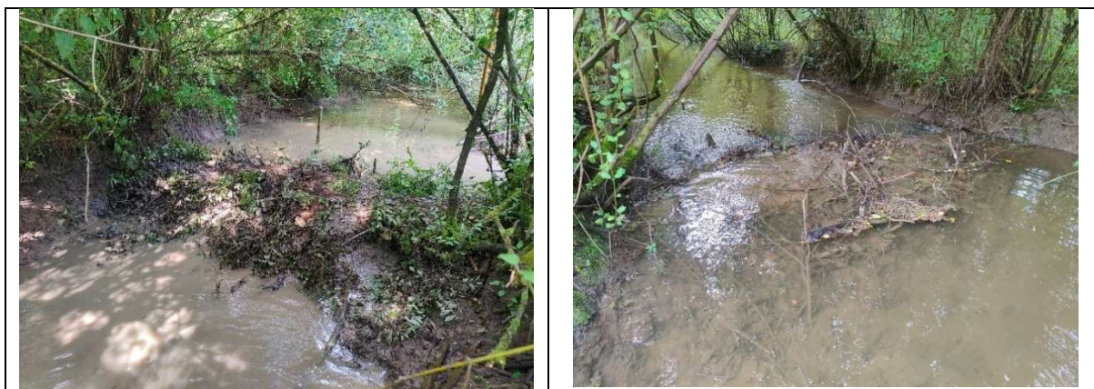
Travaux terminés - 26 juin 2025
