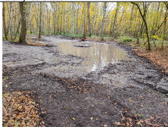
Fin des travaux (novembre 2024)
