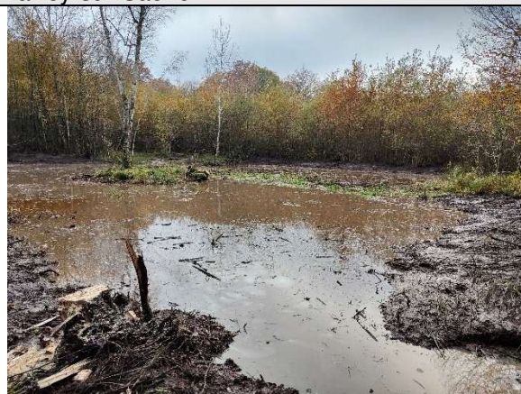
Fin des travaux (novembre 2024)
