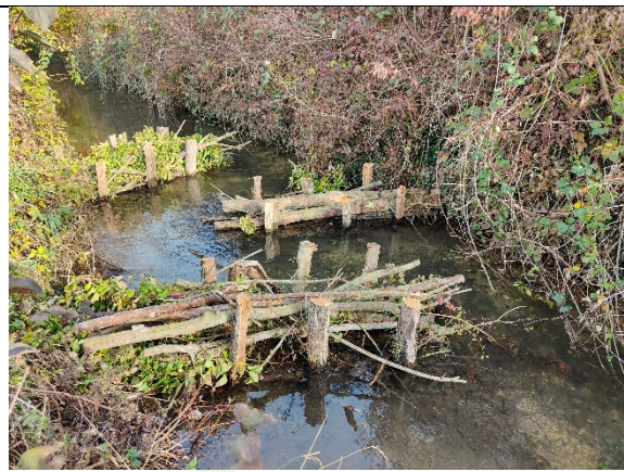
Implantation de 40 épis-fagot sur la Layer à Saulon la Chapelle (août et octobre 2024) sur 800 ml
