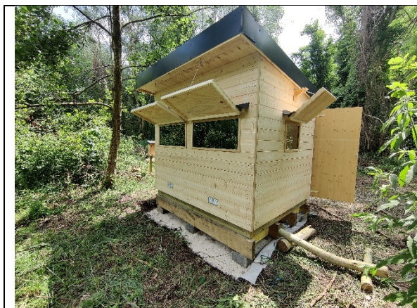
Installation de la cabane (juin 2024)
