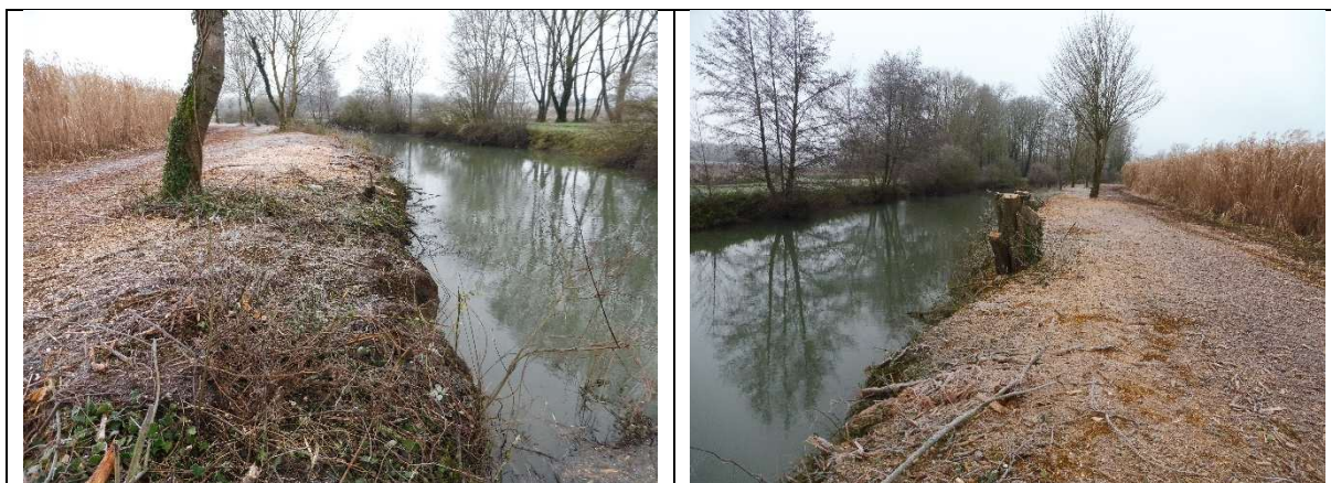
Traitement de la ripisylve (décembre 2024)
