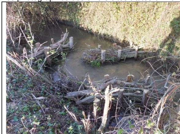
Implantation de 40 épis-fagot sur la Layer à Saulon la Chapelle (août et octobre 2024) sur 800 ml
