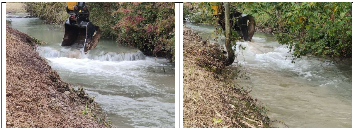
Traitement des seuils (octobre 2024)
