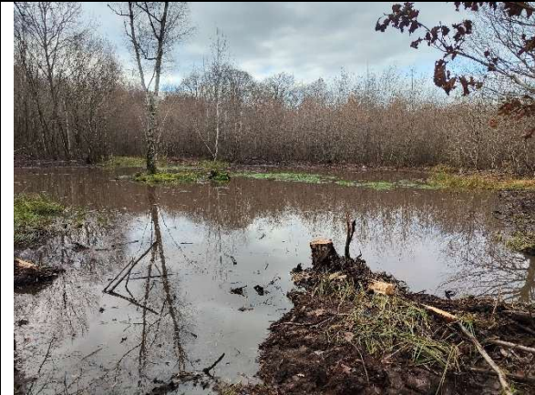
1 mois après travaux (décembre 2024)
