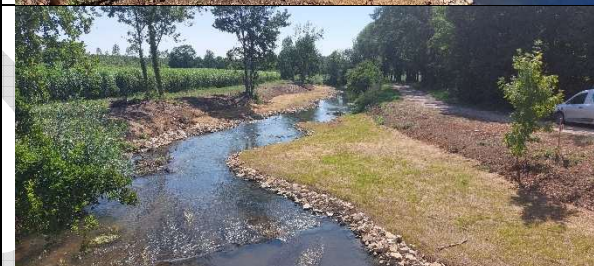
Mises en place de banquettes - 4 juillet 2025
