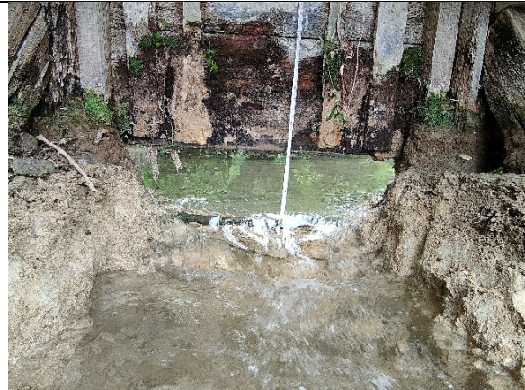
Vannes latérales du moulin (~ 20 cm de baisse)
