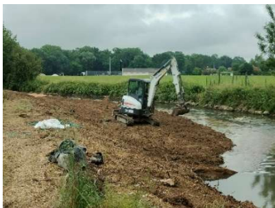
Premier retalutage des berges (mai 2025)
