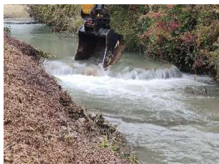
Démantèlement des seuils et traitement de la ripisylve (oct. 2024)
