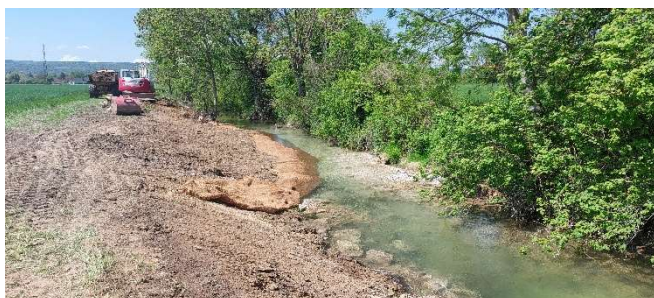
Pose de la première banquette végétale (avril 2025)
