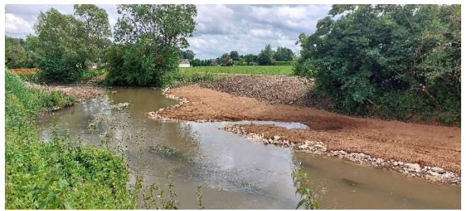
Création d'une première baissière (juin 2025)
