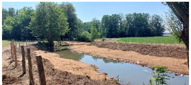
Pose de clôture et création de banquettes an amont (juin 2025)
