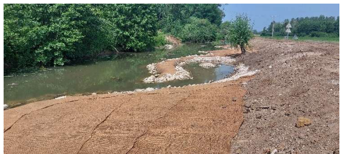
Création d'une deuxième baissière (juin 2025)
