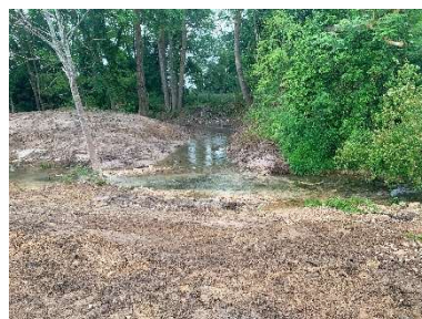
Curage et reconnexion par l'aval du méandre (mai 2025)
