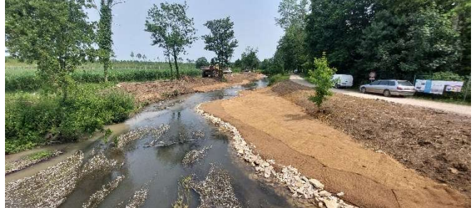
Création d'une banquette au droit du pont de la RD (Juin 2025)
