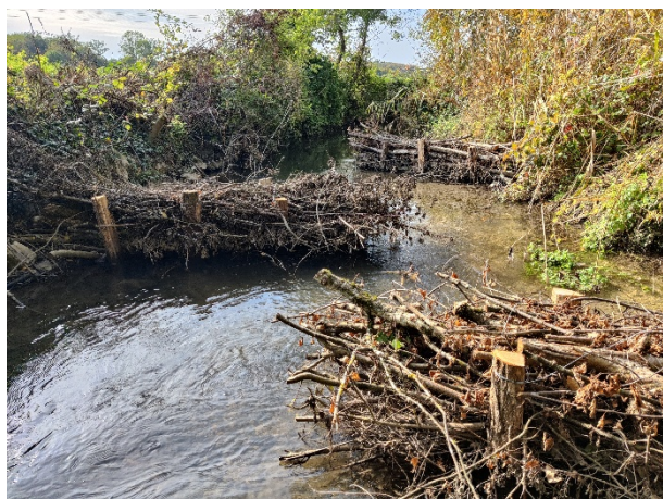
Pose d'épis-fagots à partir d'ormes secs (Varaude – juillet 2023)
