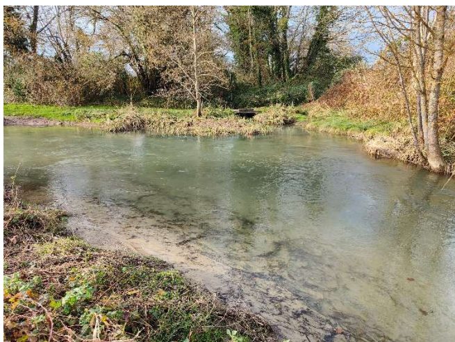
Décolmatage du lit au « Creux tournant » (nov. 2024)
