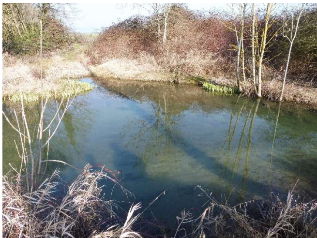
Colmatage du lit au « Creux tournant » (fév. 2022)
