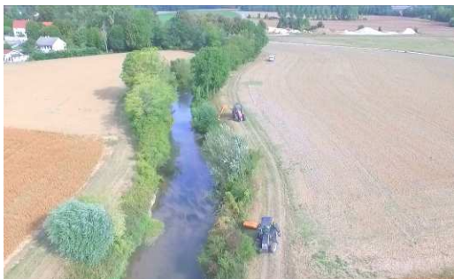
Travaux de débroussaillage
