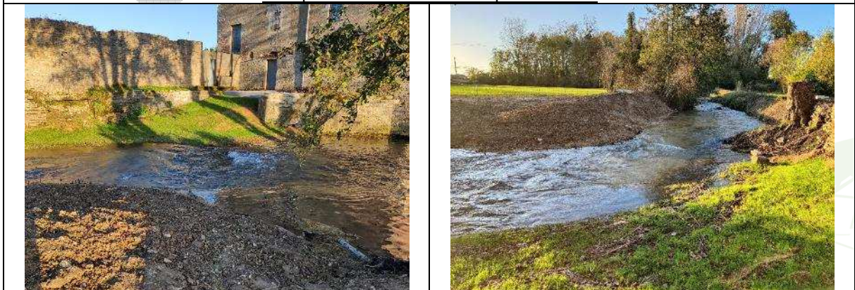
Le moulin restauré 1 mois après la fin des travaux
