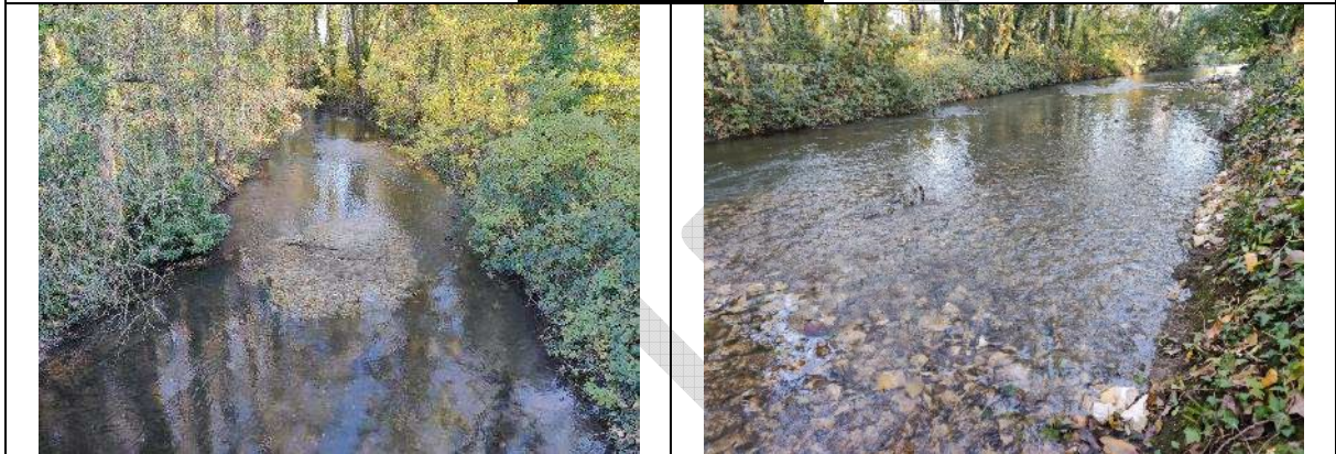
Banquettes minérales 1 mois après la fin des travaux
