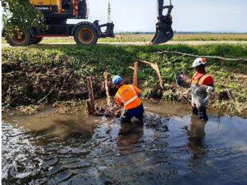
Implantation de souches immergées pour la restauration des habitats aquatiques
