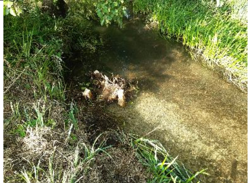
Implantation de souches immergées pour la restauration des habitats aquatiques
