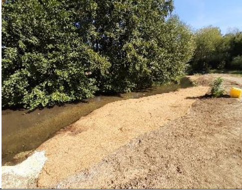
Banquettes végétales et injection de matériaux alluvionnaires
