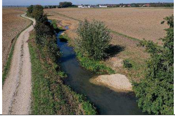
Banquettes végétales et injection de matériaux alluvionnaires
