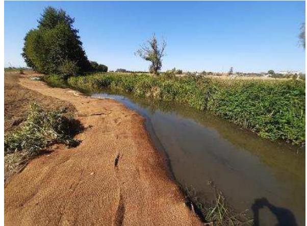
Création d'une banquette
