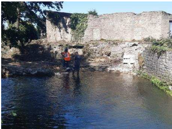
Arasement du seuil
