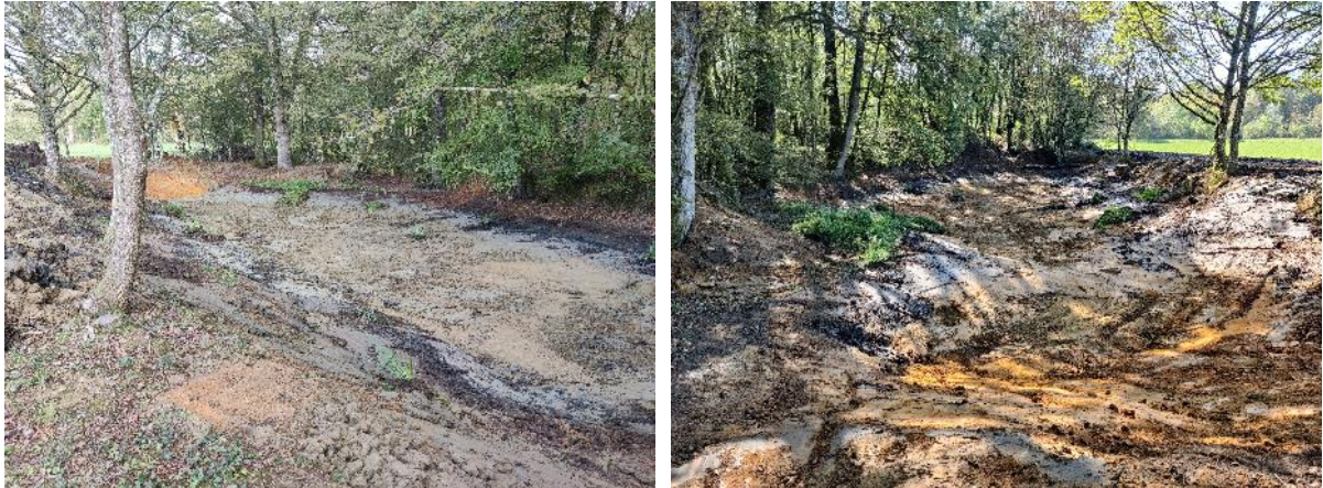
Curage hétérogène de la mare (septembre 2023)
