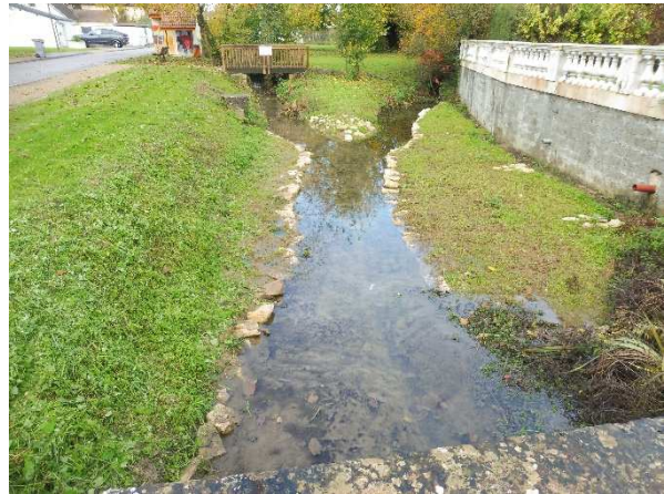
Novembre 2022 (après travaux)
