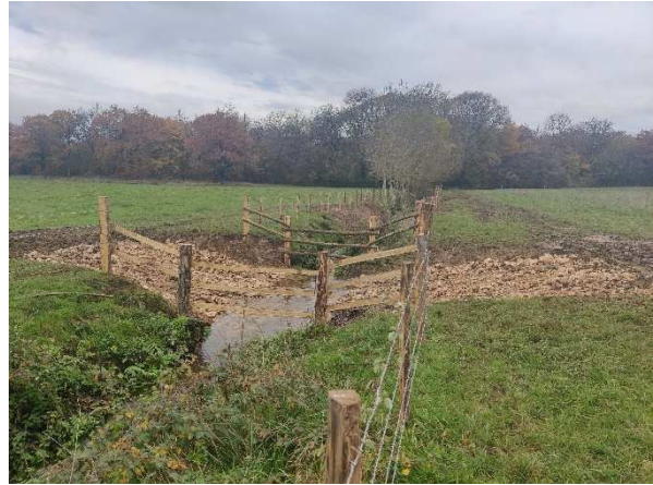
Novembre 2022 (après travaux)
