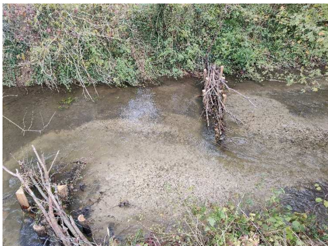
La Varaude Octobre 2022 (1 mois après les 1 ers travaux)
