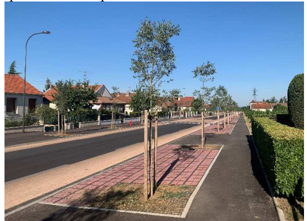
Désimperméabilisation de l'avenue de la Gare à Gevrey-Chambertin
