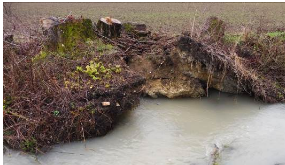
Berge après intervention (septembre 2019)
