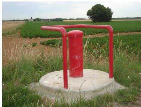
Piezomètre réhabilité à Perrigny les Dijon – octobre 2014
