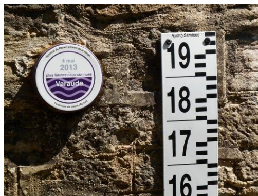
Exemple de repères de crues
